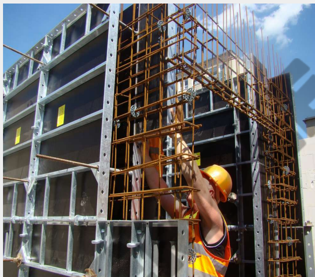
System Enco pozwala na wykonanie ścian do wysokości 3m. Lekkie płyty ułatwiają montaż bez konieczności użycia żurawia. Na zdjęciu szalowanie szybu windowego.
